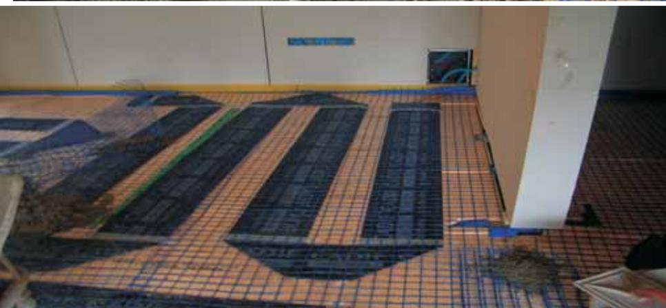
***Esempio di posa impianti e riscaldamento. In questo caso si tratta di riscaldamento elettrico a pavimento con termoguaina. Nulla ci vieta comunque di installare qualsiasi genere di riscaldamento***
