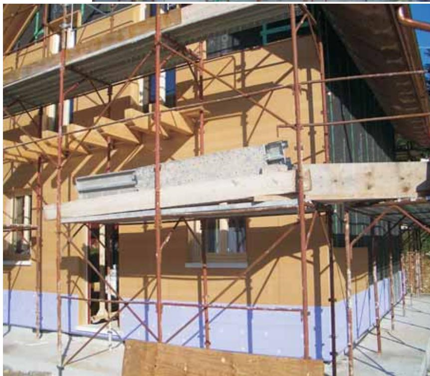
***Davanzali in Marmoresina, Coibentazione esterna in fibra di legno e tamponamento delle pareti in fibrogesso sono a testimoniare la qualità delle ns.costruzioni***
